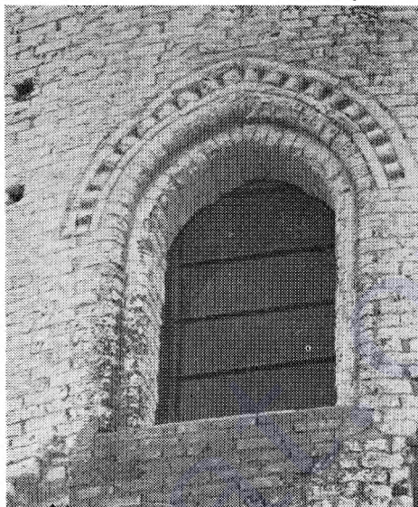
Рис. 55. Каменецкая башня. Декор окна, выполненный из профильного кирпича. Архив ЛОИА
