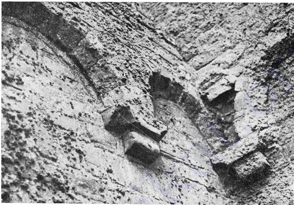
Рис. 58. Храм в д. Сынковичи. Профильный кирпич в кладке здания
