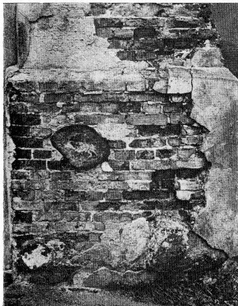
Рис. 43. Гродно. Монастырь базилианок. Смешанная кладка нижней части здания. XVIII в.
