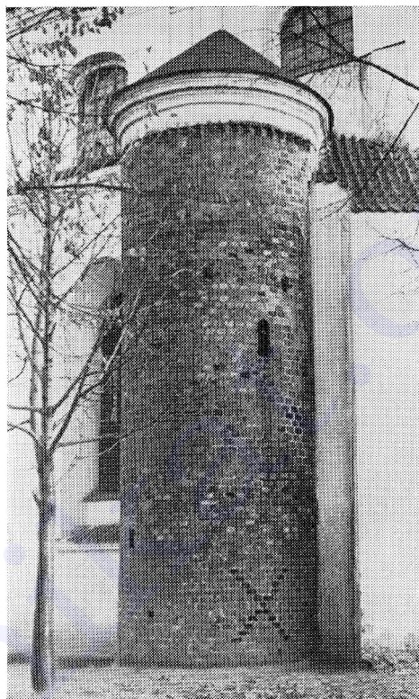
Рис. 47. Вильнюс. Бывший костел францисканцев (XV—XVIII вв.). Тычковая кладка. Фото С. Г. Багласова
