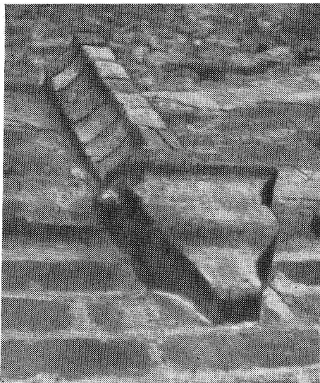
Рис. 56. Каменецкая башня. Пята готического свода, выложенная из нервюрного кирпича. Архив ЛОИА
