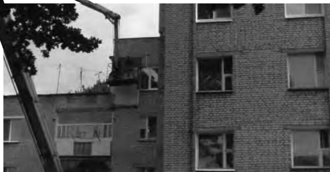
Працаўнікі КУП “Жылкампаслугі-Свіслач” выконваюць работы, якія яшчэ год таму называлі “абсалютна непрымальным, незаконным і псуочым выгляд будынкаў”
